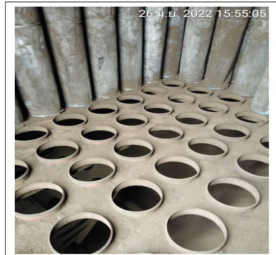
ภาพที่ 2.25 การเปลี่ยนอุ้งกรองจากระบบบำบัดอากาศ (ดำเนินการทุก 18 เดือน)
