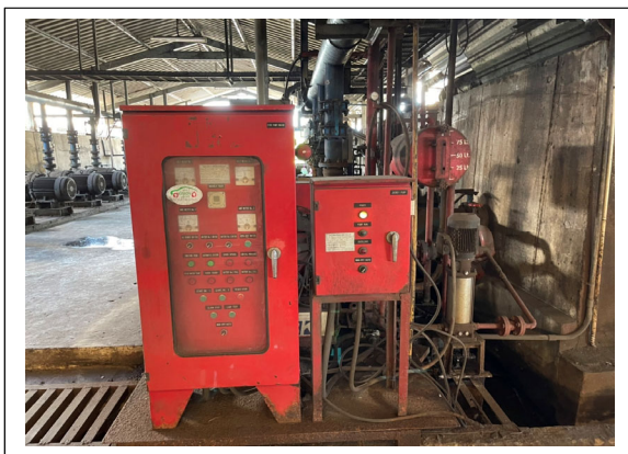
ภาพที่ 2.16 อุปกรณ์ดับเพลิงบริเวณเตาหลอม
