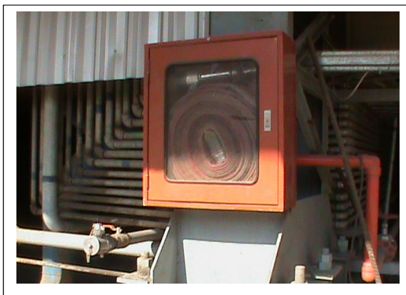
ภาพที่ 2.16 อุปกรณ์ดับเพลิงบริเวณเตาหลอม
